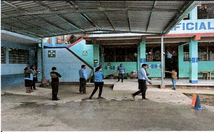
Foto 1: ÁREA DONDE SE REALIZO EL MEJORAMIENTO DE LA ESTRUCTURA DE TECHO Y LOSA DE PATIO.
